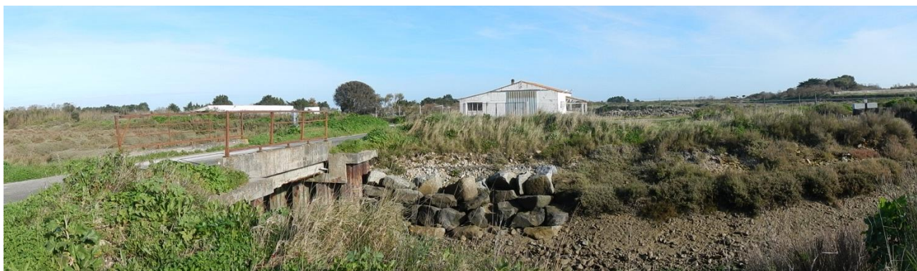
Figure 8 : Vue actuelle éloignée du pont
