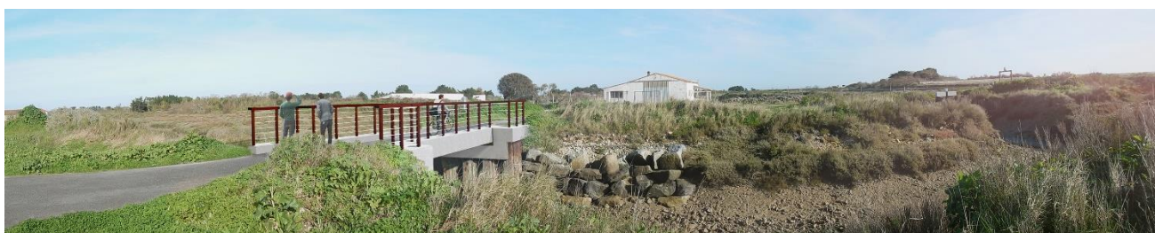
Figure 9 : Vue projetée éloignée du pont
