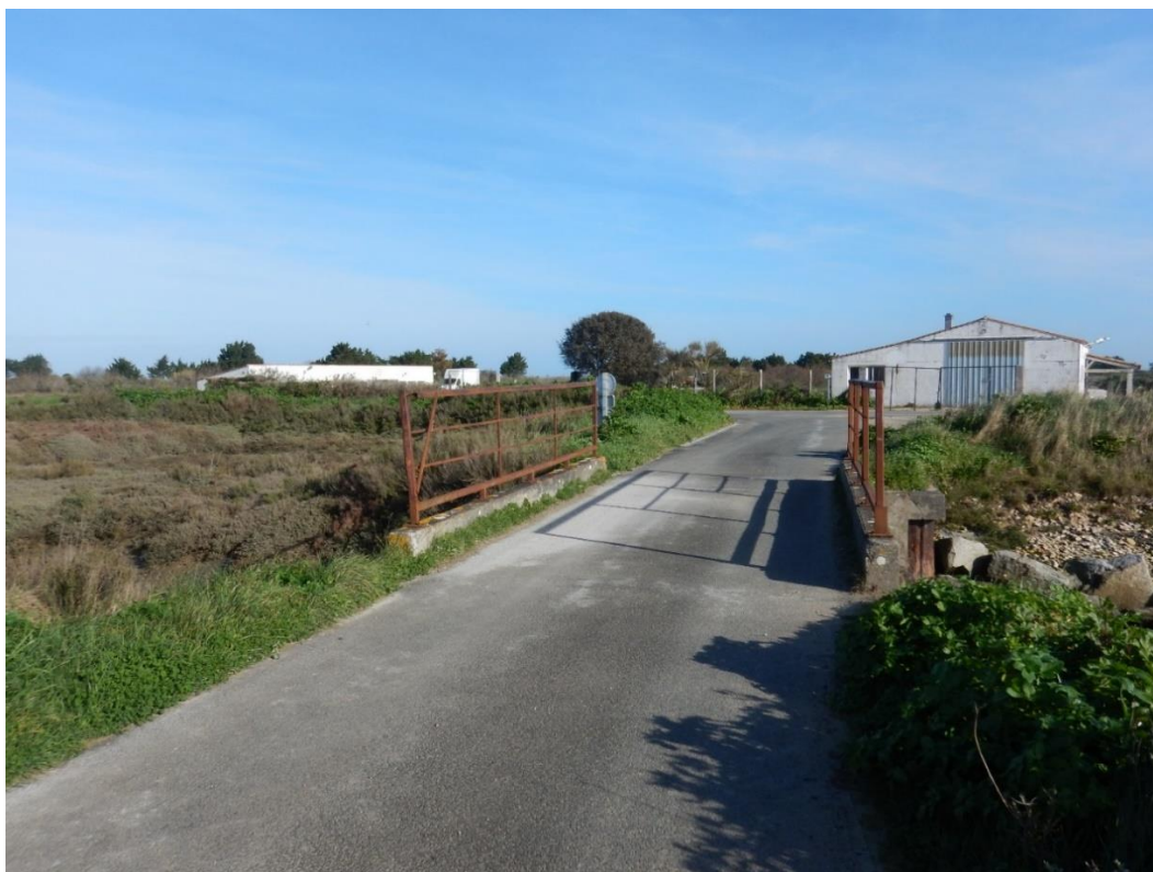
Figure 6 : Vue actuelle rapprochée du pont
