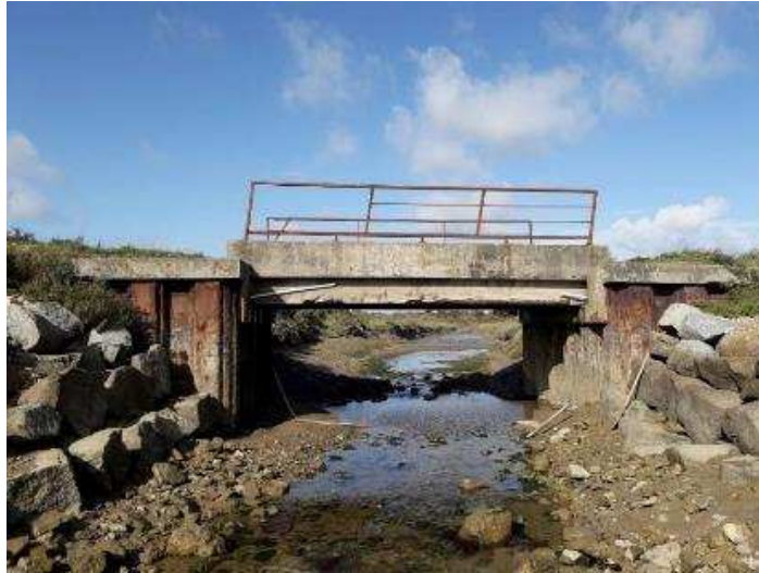
Photographie de l'ouvrage côté aval (en date du 09/10/2019)
