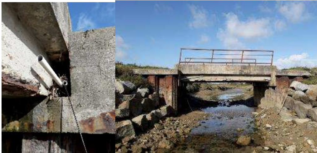
Photographie du réseau téléphonique
