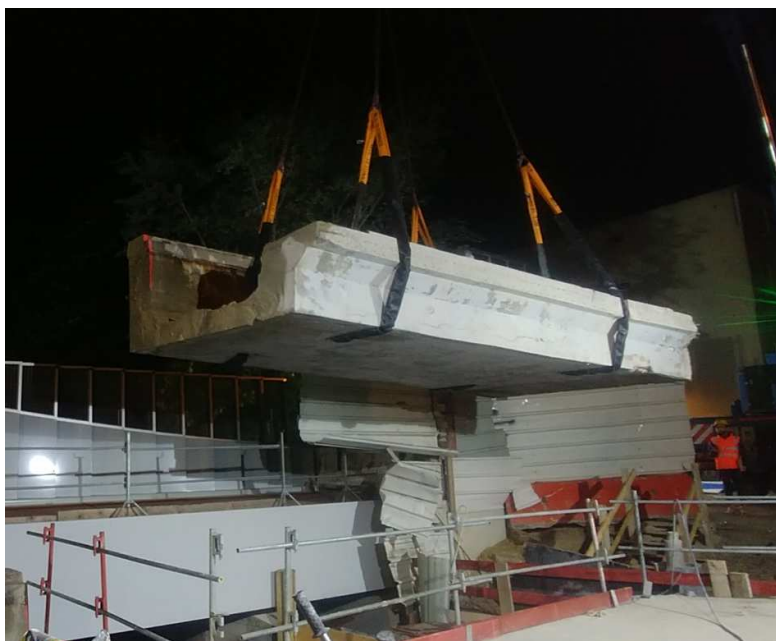
Exemple d'évacuation par grutage avec passage des élingues dans le tablier
