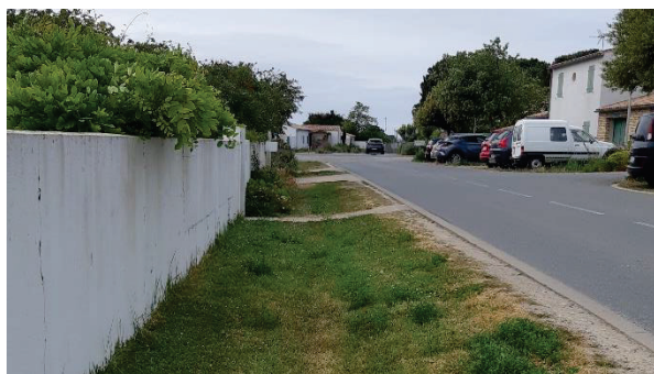
Noue urbaine - Route du Groin
