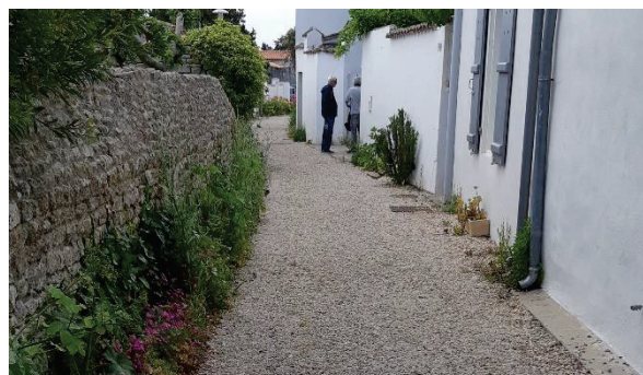
Massif enterré sous allée piétonne - Rue des Charrettes
