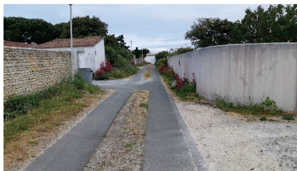
Massif enterré sous voirie - Rue des Minées
