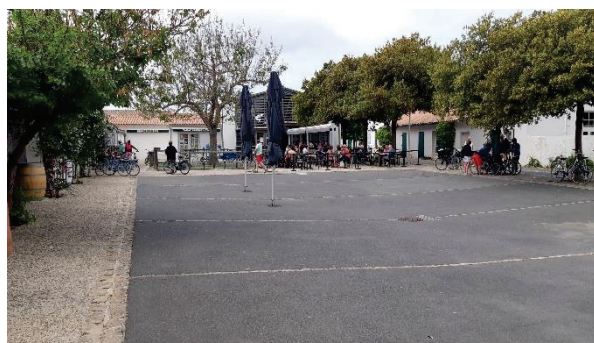
Puisard sous la place piétonne - Place du Marché
